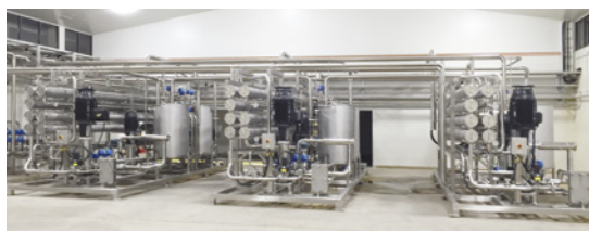
Das während der Verarbeitung aus der Milch rückgewonnene Wasser wird in einer GEA Umkehrosmoseanlage gefiltert.
